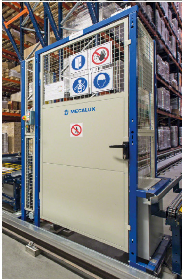
Cerramientos de zonas de control y mantenimiento
