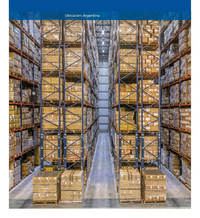
Libus, fabricante de elementos de protección personal, ha ampliado su centro de producción en Berazategui, al sudeste de Buenos Aires, con la construcción de un nuevo almacén autoportante. En esta instalación, la compañía gestiona 2.340 palets con materias primas, productos semielaborados y terminados que posteriormente distribuye a sus clientes en Argentina.
